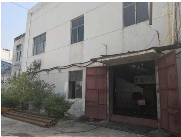
探伤机拟安装的主井房
