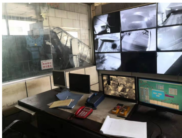
探伤机控制室
