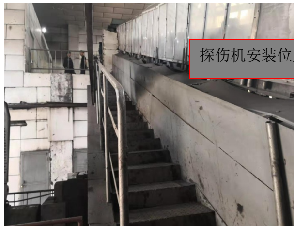
探伤机拟安装位置西侧
