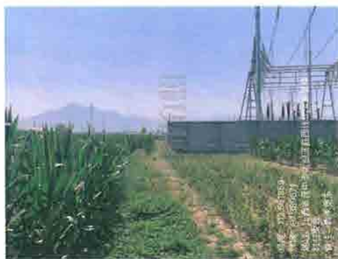
贯家堡变电站东侧
