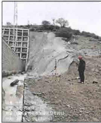
升压站西南侧电磁场监测
