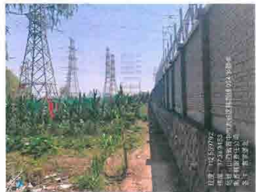
贯家堡变电站北侧
