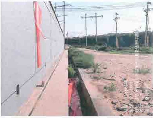
胡村变电站东侧
