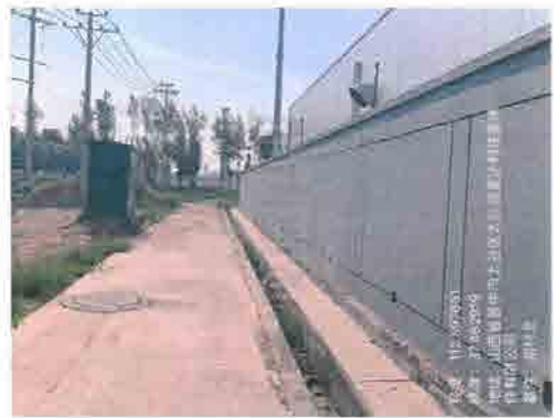
胡村变电站北侧
