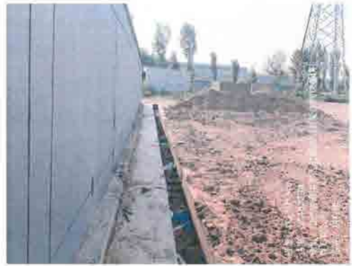
胡村变电站南侧
