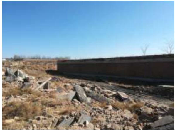
厂区南侧现状
