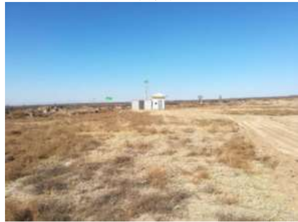
厂区北侧现状
