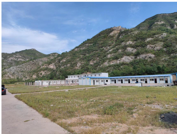
本项目拟利用施工营地
