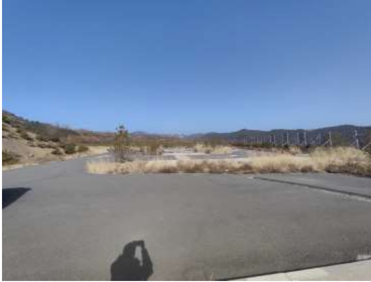
进场道路现状
