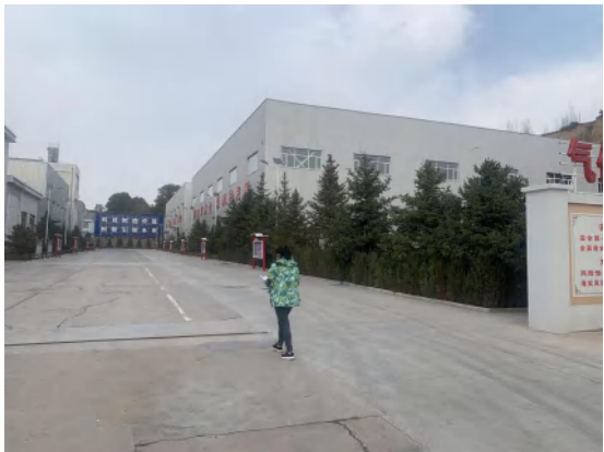
项目西侧（厂区道路）
