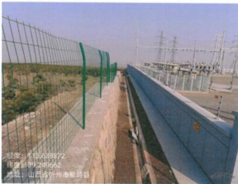
溇源 220kV 变电站西侧
