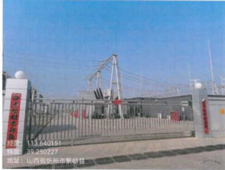
溇源 220kV 变电站东侧
