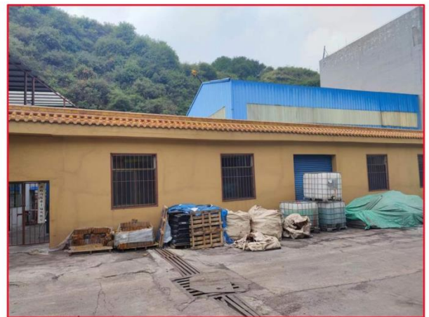
回风井风机房
