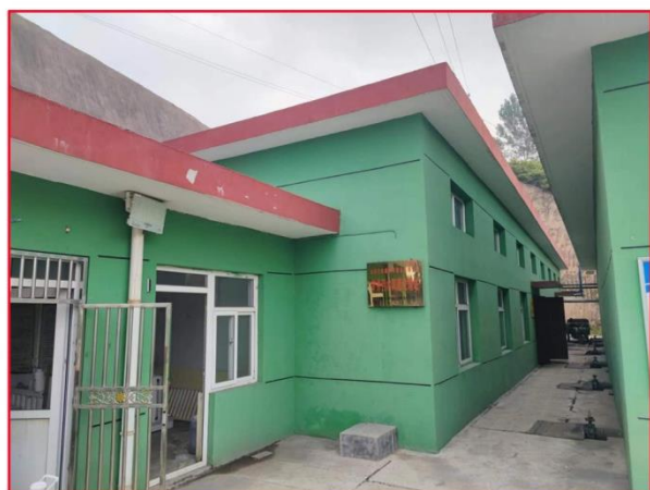
矿井水处理站
