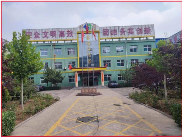
鑫峪沟煤矿办公楼
