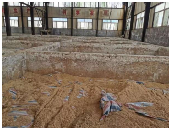
现有车间发酵池
