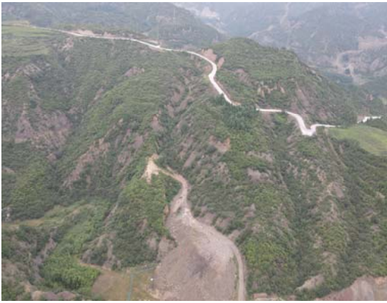
项目北侧（大山）
