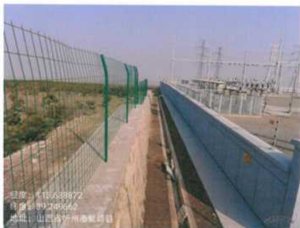
溇源 220kV 变电站西侧
