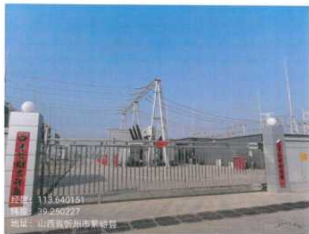
溇源 220kV 变电站东侧
