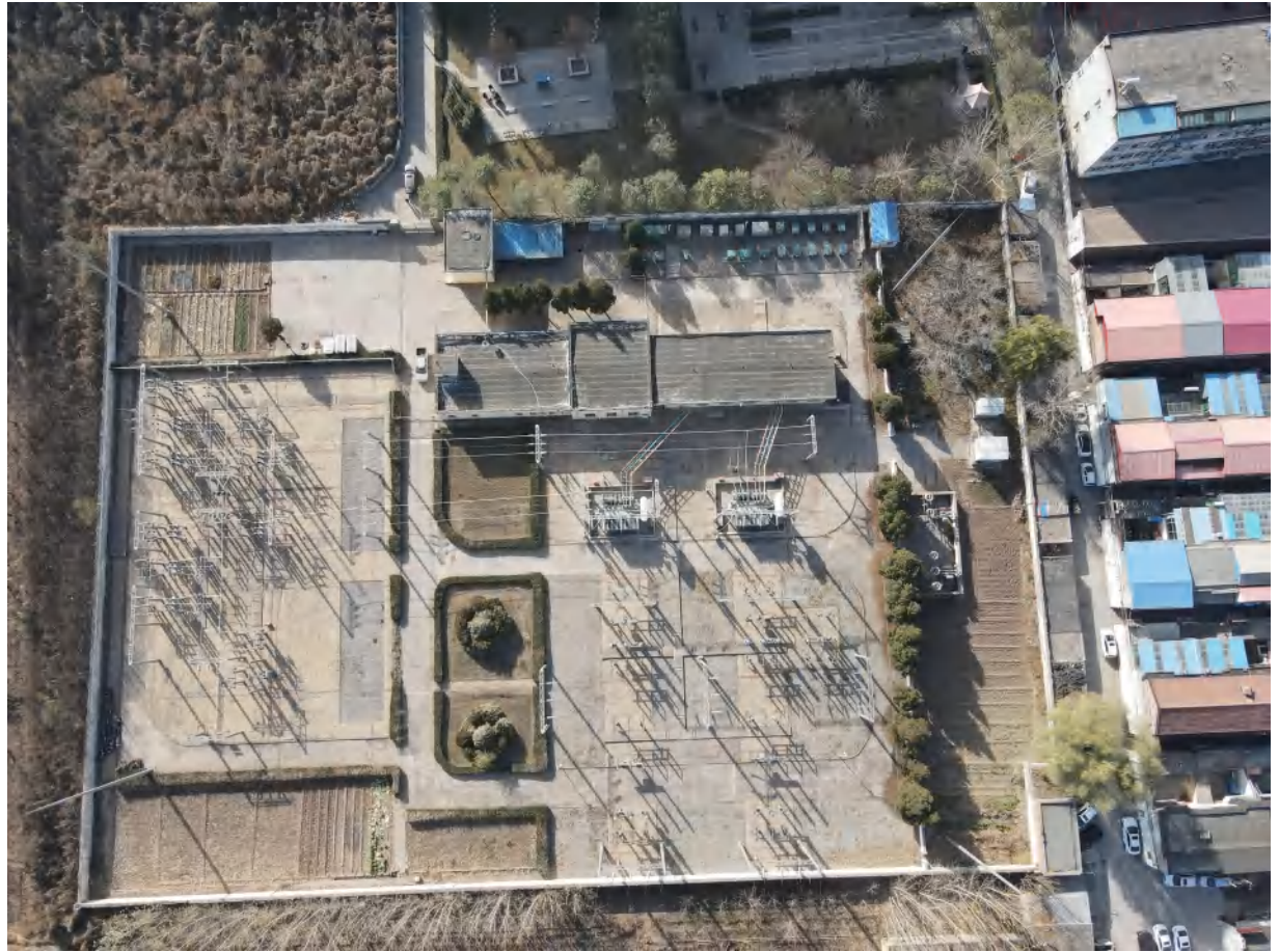
变电站俯瞰全貌
