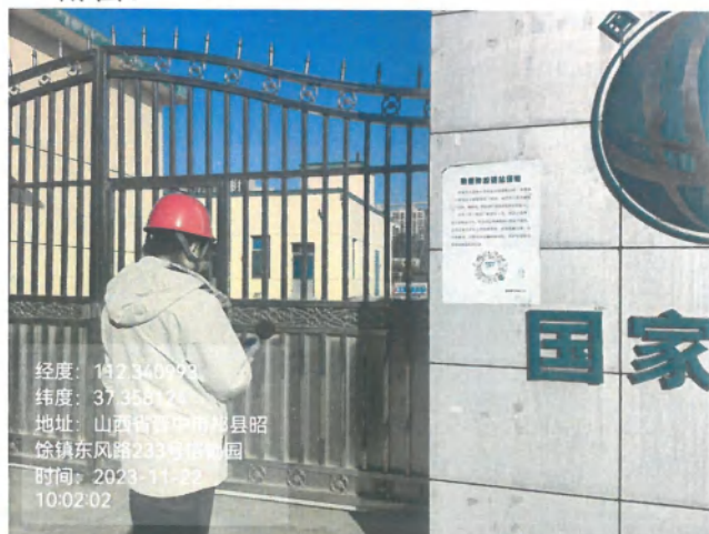
祁县 110kV 变电站南侧
