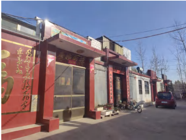
变电站西北侧民房
