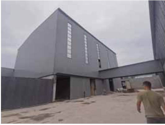
浮选压滤车间(左)、原矿储库(右)
