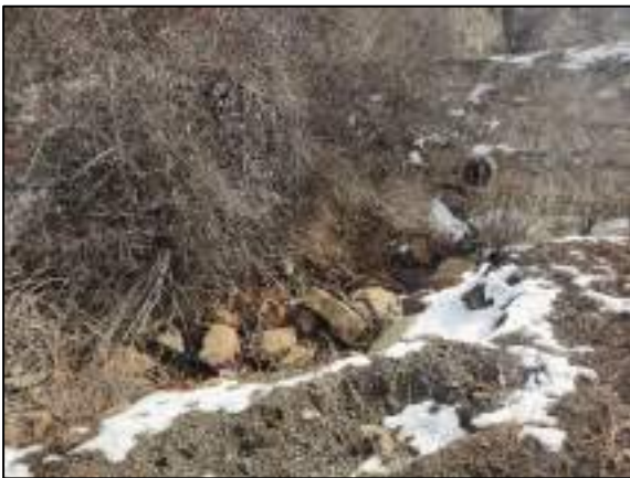
荡荡岭备用矸石场拦渣坝、排水涵洞
