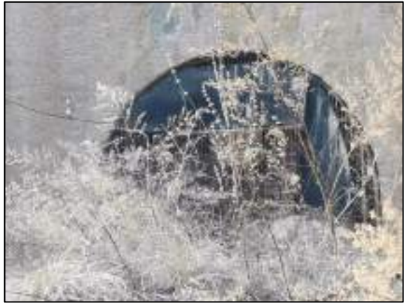
冯家坛已封闭副井井口
