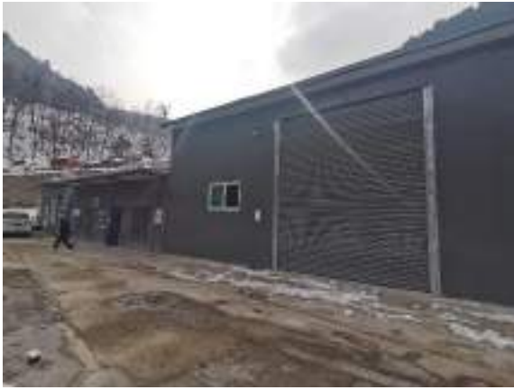
荡荡岭矿井水处理站
