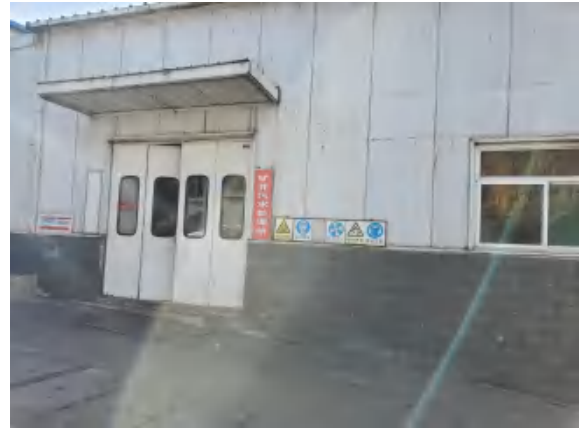
矿井水处理站（改造）
