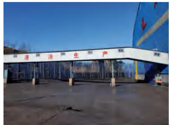
输煤廊道（利用）
