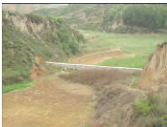
矸石场沟口拦矸坝
