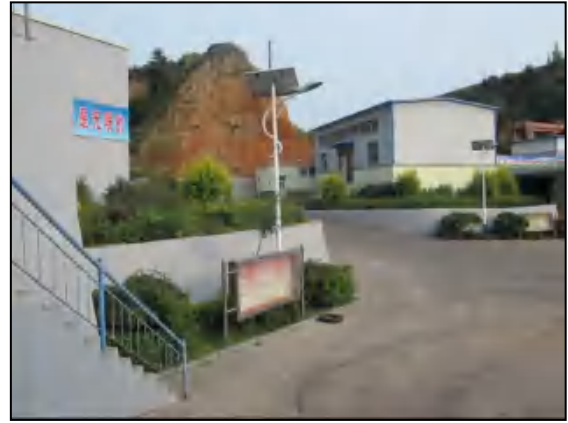
主副井工业广场已经采取的绿化措施
