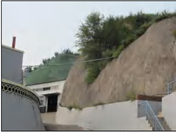
主工业场地已有的护坡、挡墙的措施
