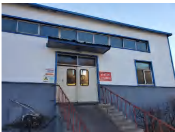
副井提升机房（利用）
