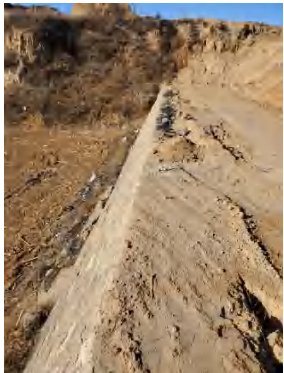
矸石场拦渣坝
