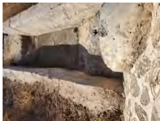
矸石场消力池
