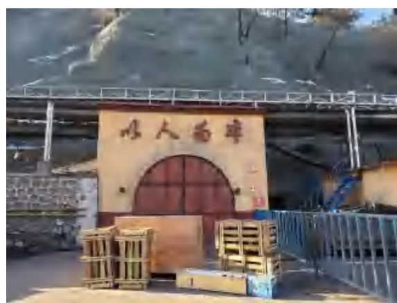
进风斜井（原回风井）
