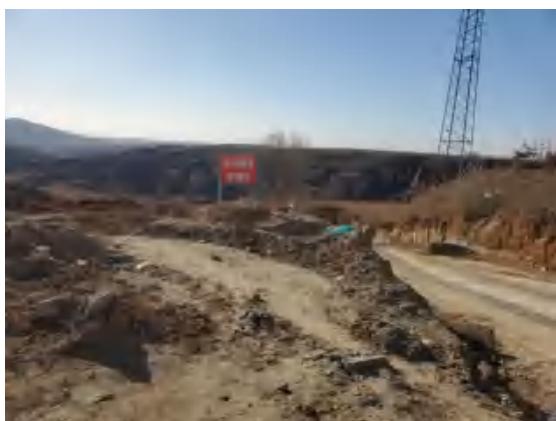
矸石场西侧运矸道路现状
