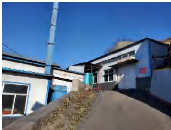
筛分车间排气筒（利用）
