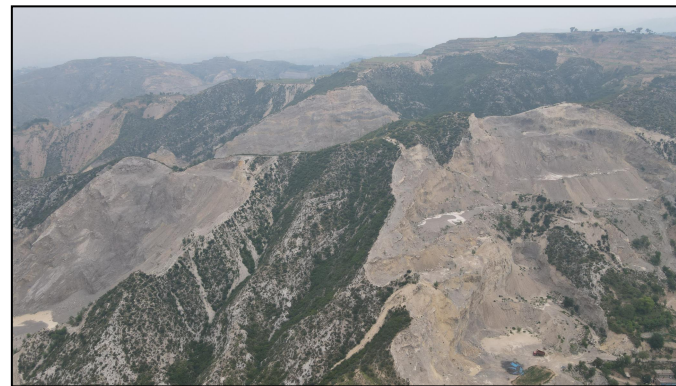
光伏片区占地
