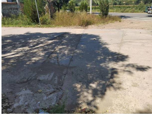
穿越路面工程现状
