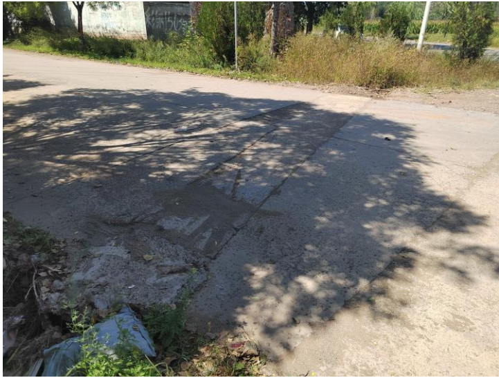
管线穿越工程路面
