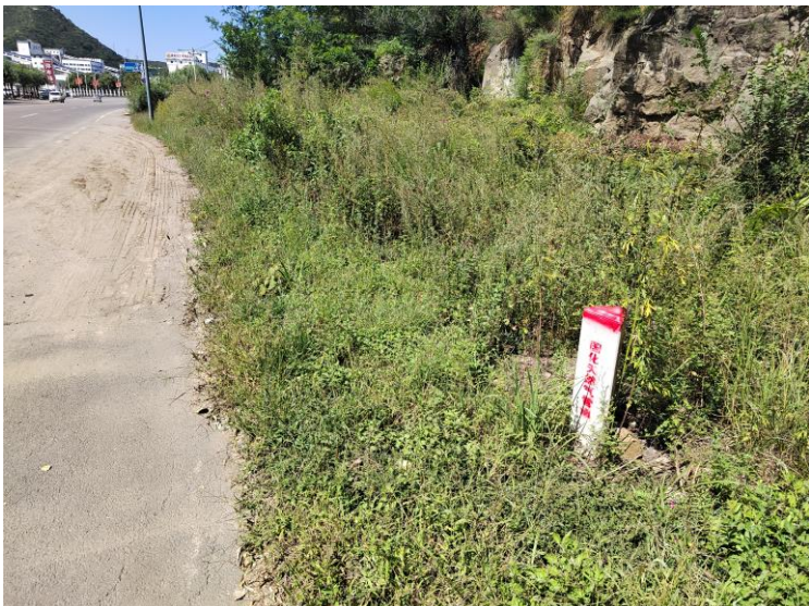
管线走线路面现状
