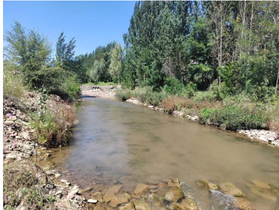
开挖工程河道恢复现状
