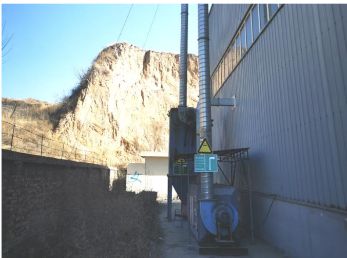
固化工序现有废气处理设施
