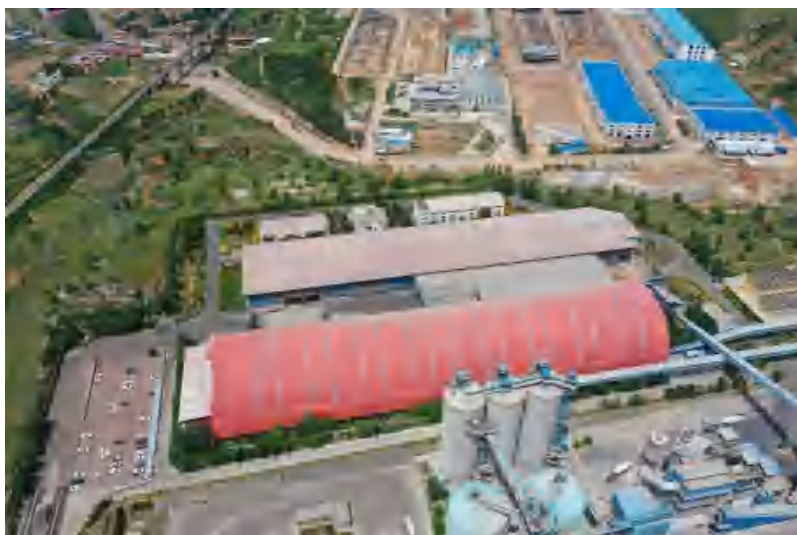
现有原料库（本次处置的一般固体废物拟暂存于该库）
