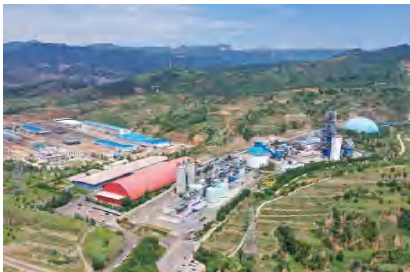
左权金隅水泥有限公司全景
