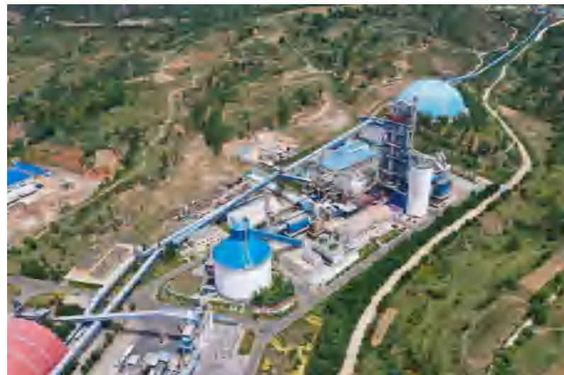
左权金隅水泥有限公司水泥回转窑
