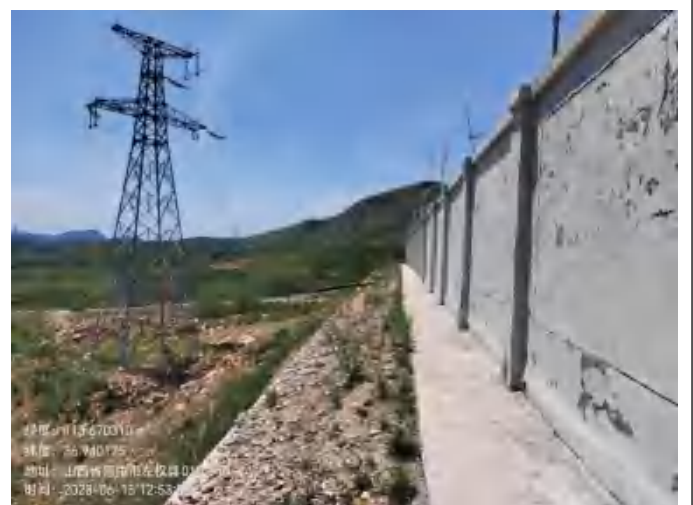
羊角风电 110kV 升压站南侧
