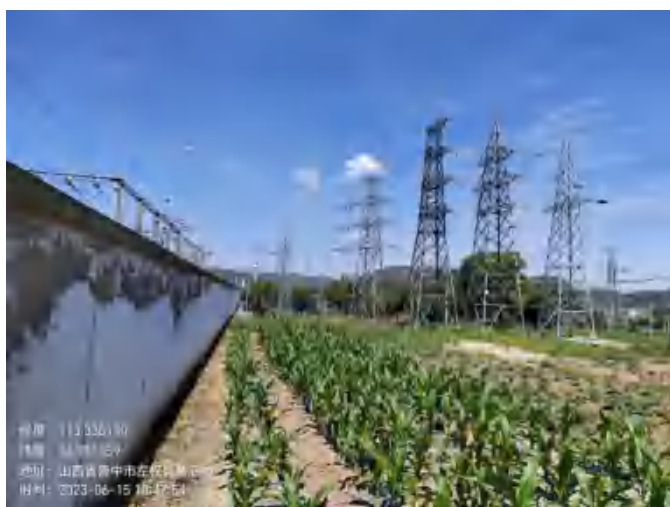
漳河 110kV 变电站北侧
