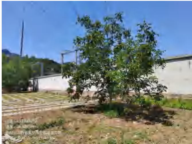
上武 110kV 变电站东南侧
