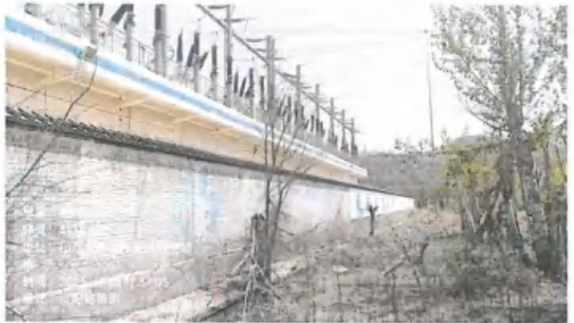
辽阳 220kV 变电站西南侧
