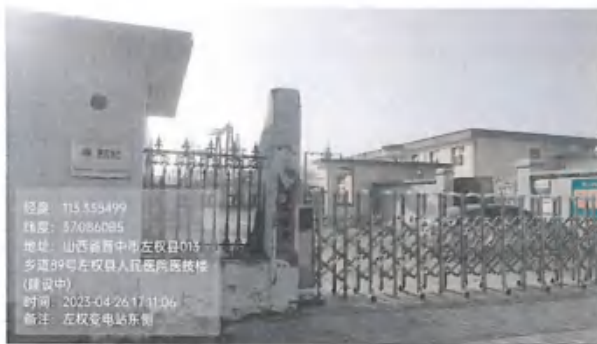
左权 110kV 变电站东侧
