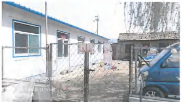
线路东北侧 5m 突堤村民房
