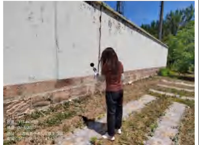
上武 110kV 变电站东南侧
