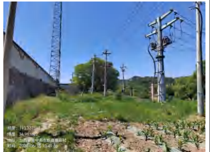
漳河 110kV 变电站西侧
