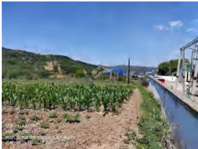
漳河 110kV 变电站南侧
