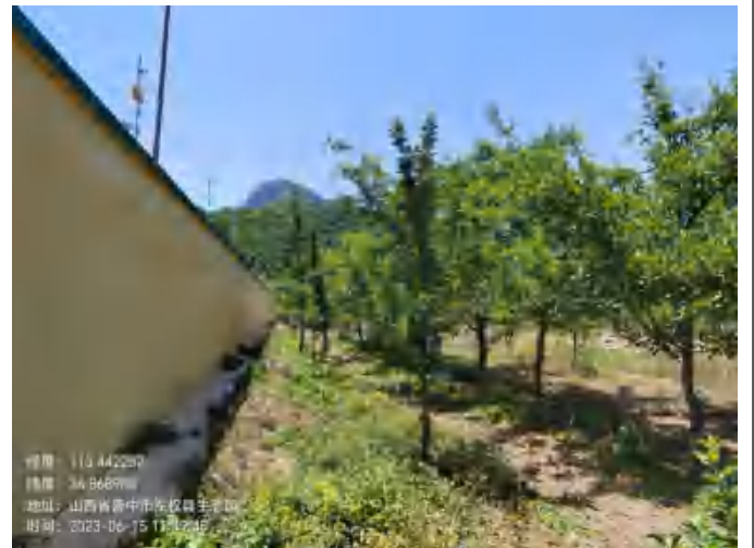
上武 110kV 变电站西北侧
