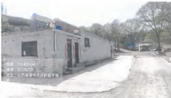
线路跨越石料厂办公区
