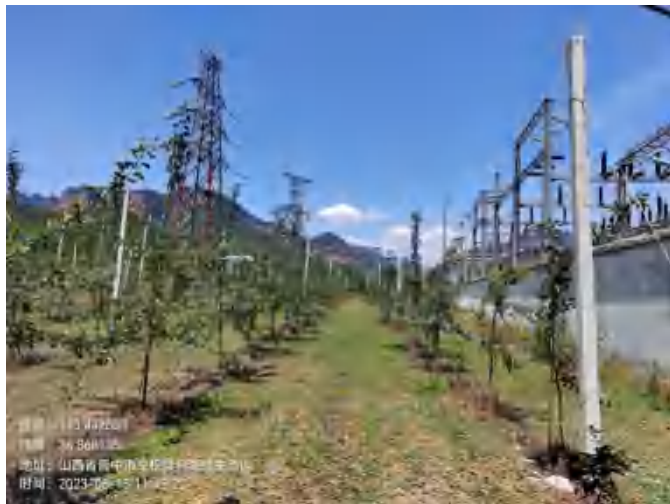
上武 110kV 变电站西南侧
