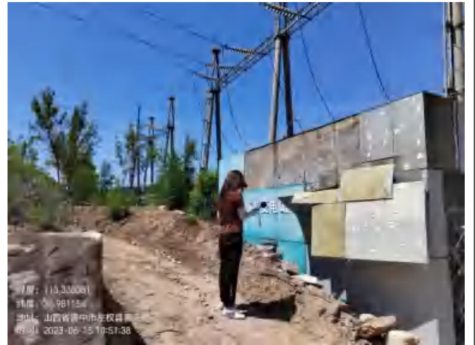
漳河 110kV 变电站东侧
