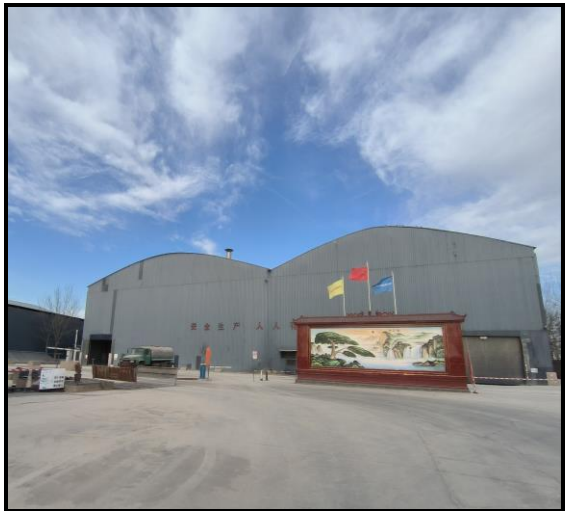
现有水稳拌合站
