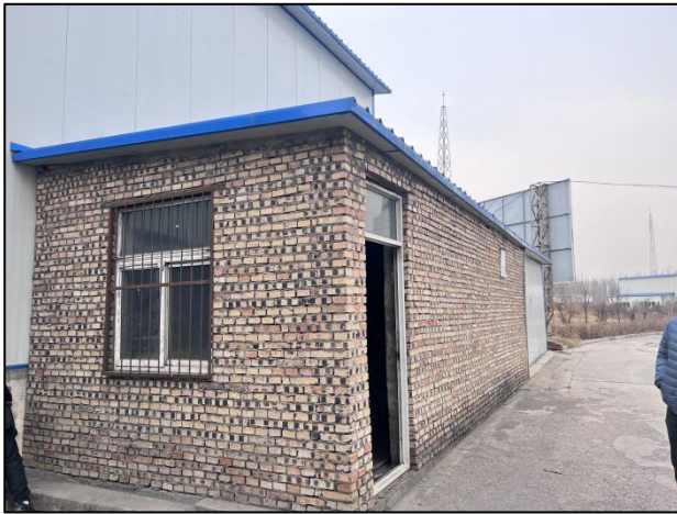
拟建无损检测装置控制室
