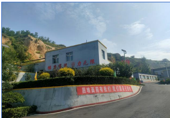
东侧 60m 办公楼
