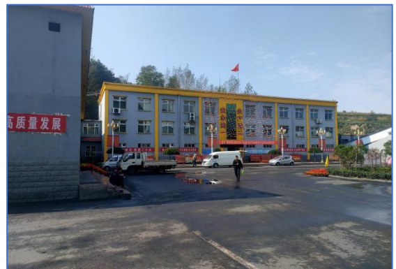
东南 60m 调度楼
