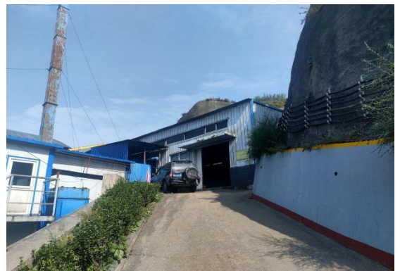
东北 50m 压风机房
