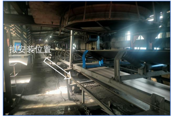
无损检测装置拟安装位置环境
