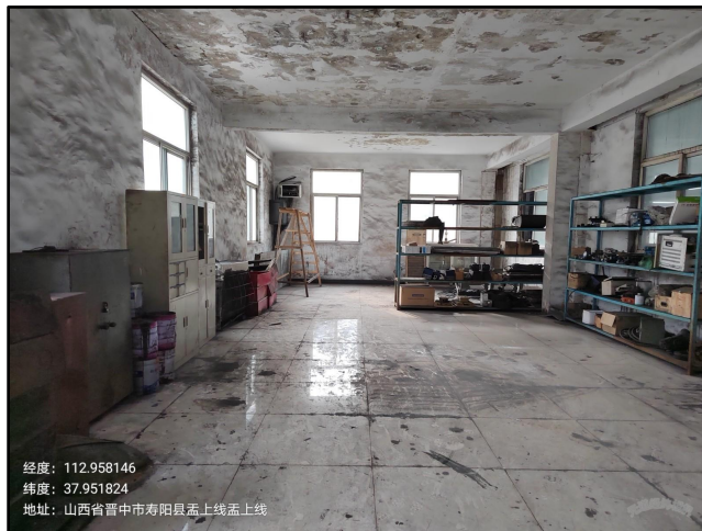
主斜井井口房内库房
