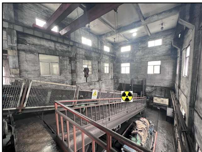
主斜井井口房皮带无损检测装置拟安装位置
