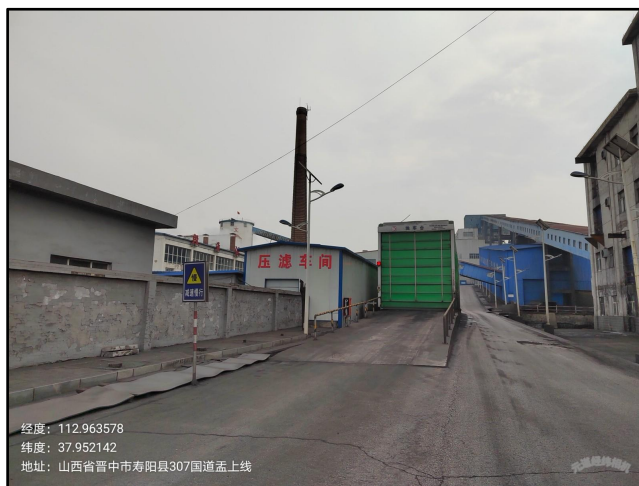
压滤车间及锅炉房
