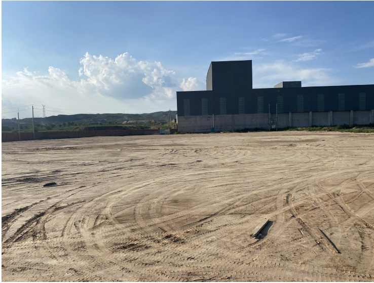
水稳生产线厂址现状
