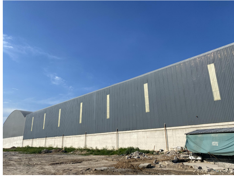
现有混凝土搅拌站砂石库
