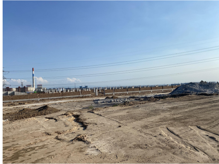
水稳生产线厂址现状
