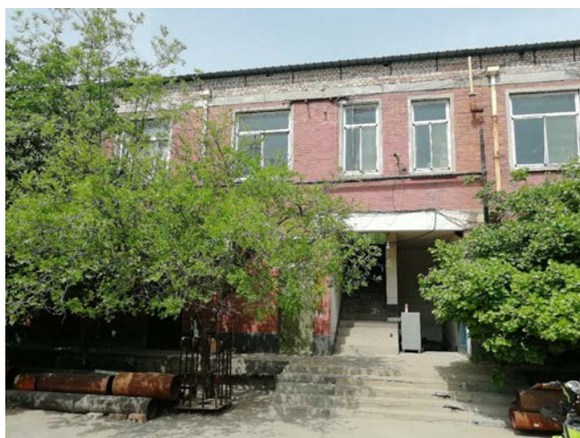
北侧榆缆集团办公房
