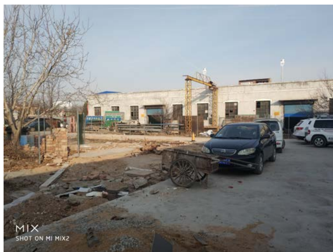
东侧榆缆集团生产厂房
